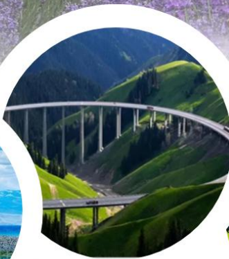
สะพานกัวจื่อโก
