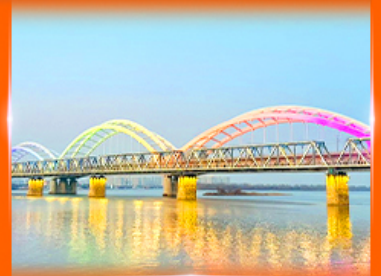
สะพานรถไฟปินโจว
