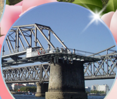
สะพานขาดตานตง
