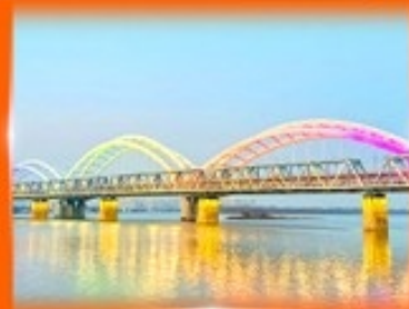
สะพานรถไฟผืนโจว
