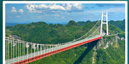
สะพานอายจ้าย
