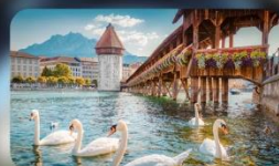
สะพานไม้ซาเปล
