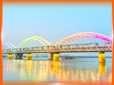
สะพานรถไฟปินโจว
