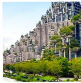
อาคารพันต้นไม้ Tian An 1000 Trees
