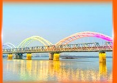
สะพานรถไฟพินโจว
