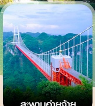
สะพานอ้ายจ้าย
