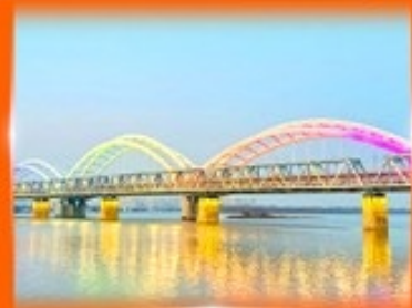
สะพานรถไฟผืนโจว
