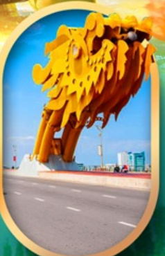
สะพานมังกรคานัง
