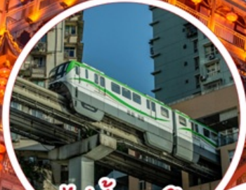
รถไฟฟ้า-ลูตีก Liziba Station
