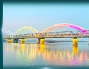
ชมวิวดสะพานรุทไฟป็นใจ
