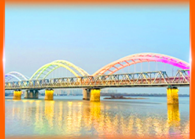
สะพานรถไฟปินโจว
