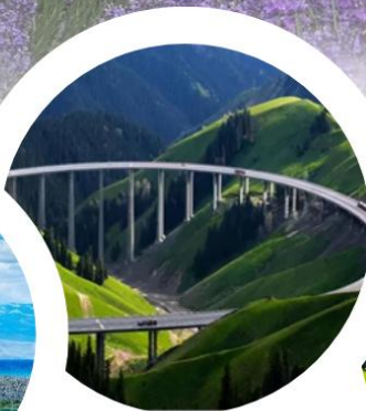
สะพานกัวจื่อโก
