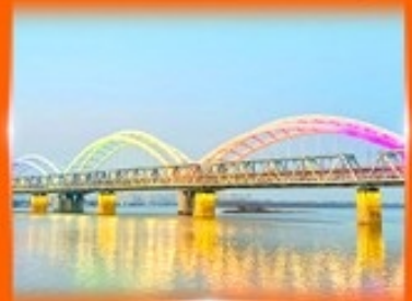
สะพานรถไฟผืนโจว
