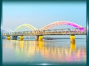
ชมวิวสะพานรุทไฟป็นใจ
