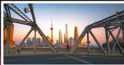
สะพานไวปี้ดู่
