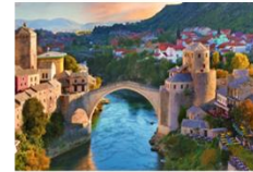
สะพานเก่า Mostar
