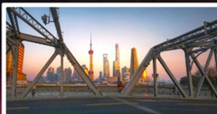
สะพานไวปี้ตู่
