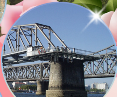
สะพานขาดตานตง
