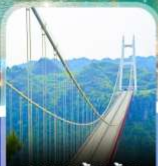
สะพานอ้ายจ้าย
