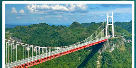
สะพานอ้ายจ้าย
