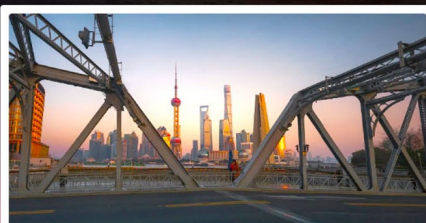
สะพานไวปี้ดู่
