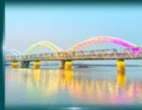
ชมวิวสะพานรุ้งไฟป็นใจ
