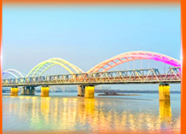
สะพานรถไฟปินโจว
