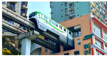
รถไฟฟ้าลัดคิว
