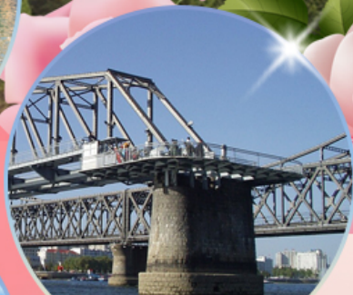
สะพานขาดตานตง
