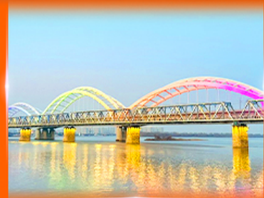
สะพานรถไฟปินโจว
