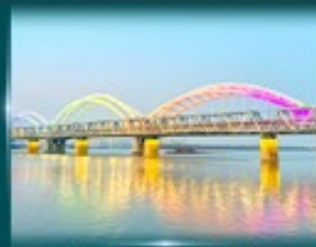
ชมวิวสะพานรุทไฟป็นใจ
