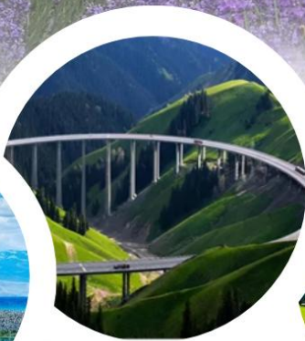
สะพานกัวจื่อโก
