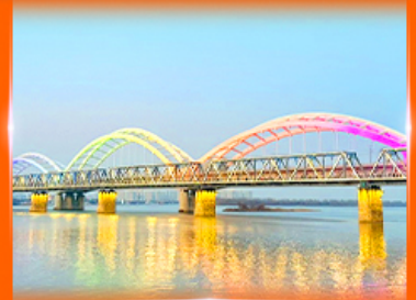
สะพานรถไฟปินโจว
