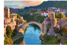
สะพานเก่า Mostar
