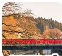
สะพานนากะบาชิ
