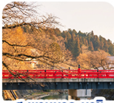
สะพานนากะบาชิ
