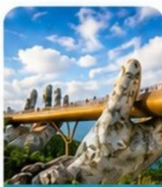
สะพานมือสีทอง
