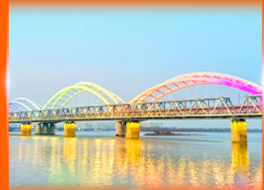
สะพานรถไฟปินโจว
