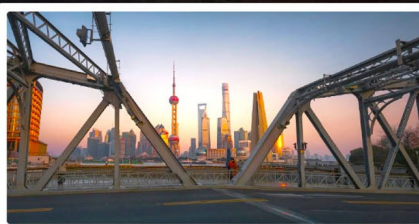
สะพานไวไปคู้
