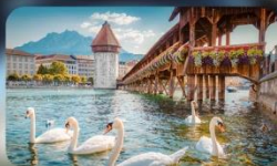
สะพานไม้ซาเปล
