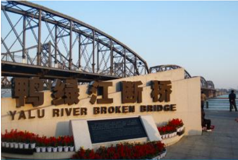
สะพานขาด
