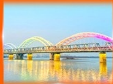
สะพานรถไฟผืนโจว
