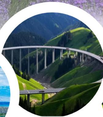
สะพานกัวจื่อโก
