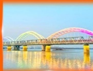
สะพานรถไฟผืนโจว
