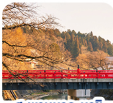
สะพานนากะบาชิ
