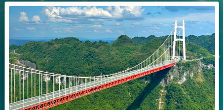
สะพานอ้ายจ้าย
