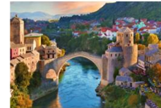
สะพานเก่า Mostar
