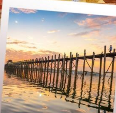
สะพานไม้จูปิง
