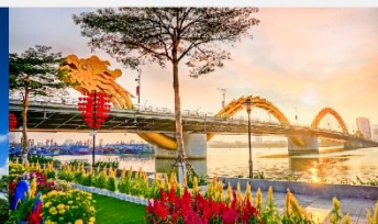
สะพานมังกร
