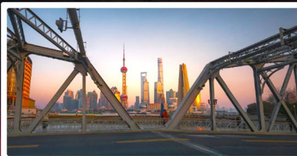
สะพานไวไปคู้
