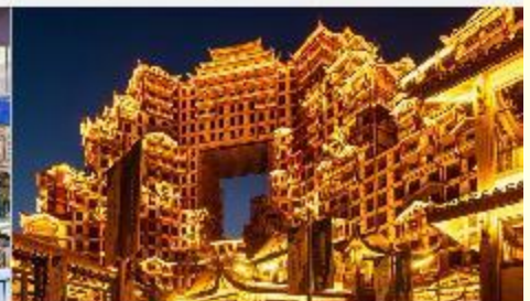
ตึกมหัศจรรย์ 72 ชั้น
